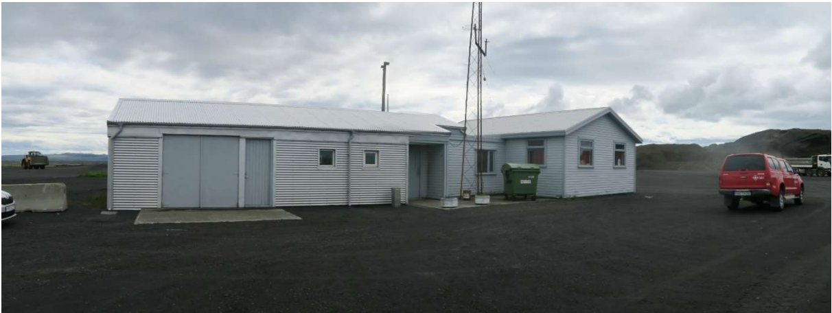
MYND 3.5 Starfsmannaaðstaða Íslenskra aðalverktaka við Súlur og Stapafell. Aðstaðan nýtist einnig starfseminni í Rauðamel. Mynd tekin af EFLU verkfræðistofu í júlí 2018.
